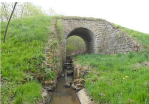
Můstek přes Rosičku na bývalé železniční trati z Nové Včelnice na Nekrasín.
